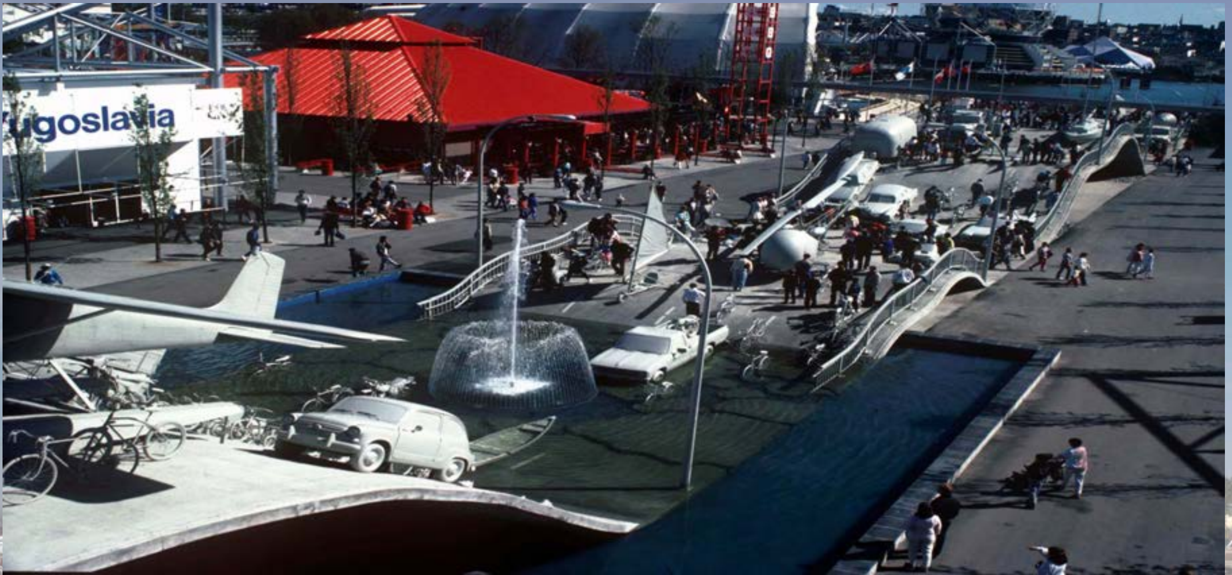
Рис. 3.3. Конкурсний проєкт на спорудження центрального експоната виставки ЕКСПО-86 у Ванкувері (Канада). Композиція «Хайвей-86», тобто «Автомобільна магістраль-86» (хвиляста стрічка з бетону і сталі для експонування всіх засобів пересування).
